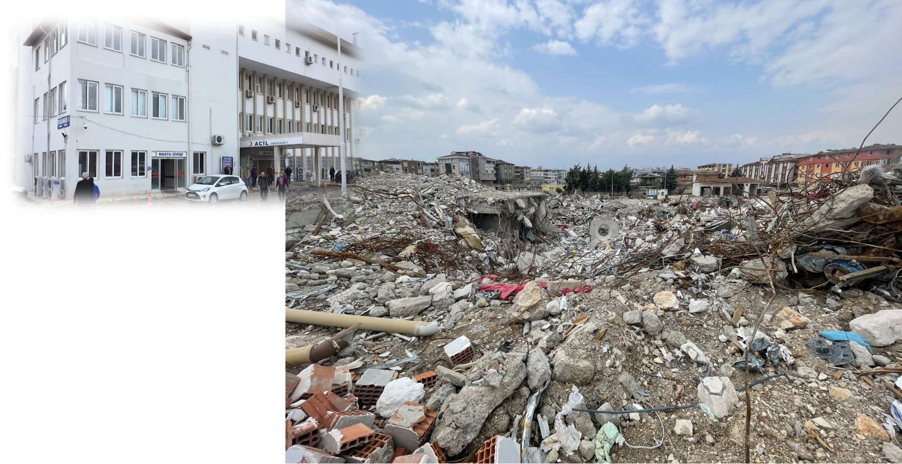
Hatay Antakya State Hospital (after rescue and demo) (Hatay Eğitim ve Araştırma Hastanesi Ek Hizmet Binası)
